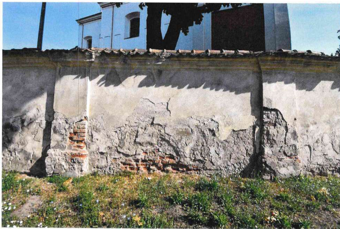
1P4 pav. Mūro erozijos, drėgmės ir šalčio paveikta tvoros apatinė dalis
