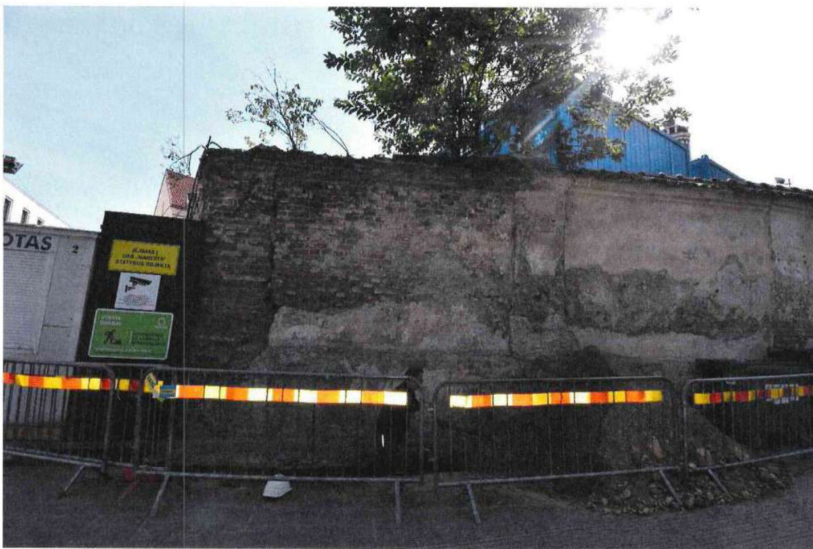
1P8 pav. Mūro erozijos, drėgmės ir šalčio paveikta tvoros apatinė dalis
