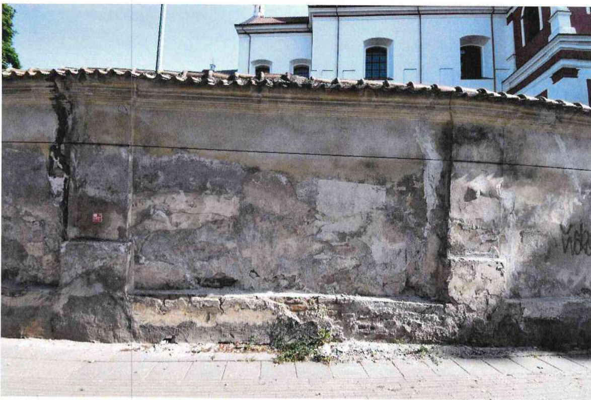
1P5 pav. Mūro erozijos, drėgmės ir šalčio paveikta tvoros apatinė dalis
