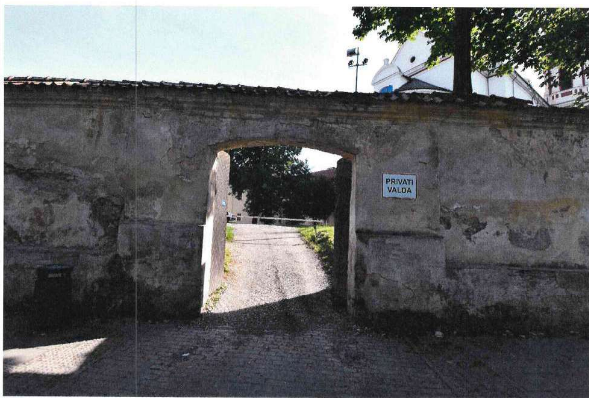
1P7 pav. Mūro erozijos, drėgmės ir šalčio paveikta tvoros apatinė dalis
