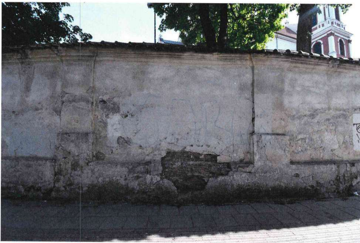
1P6 pav. Mūro erozijos, drėgmės ir šalčio paveikta tvoros apatinė dalis
